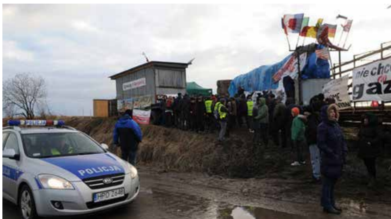
13.03.2012 r. Blokada przez mieszkańców podczas próby rozpoczęcia prac ziemnych w Żurawlowie, w tle – pracujący spychacz. Fot. Andrzej Bąk.
