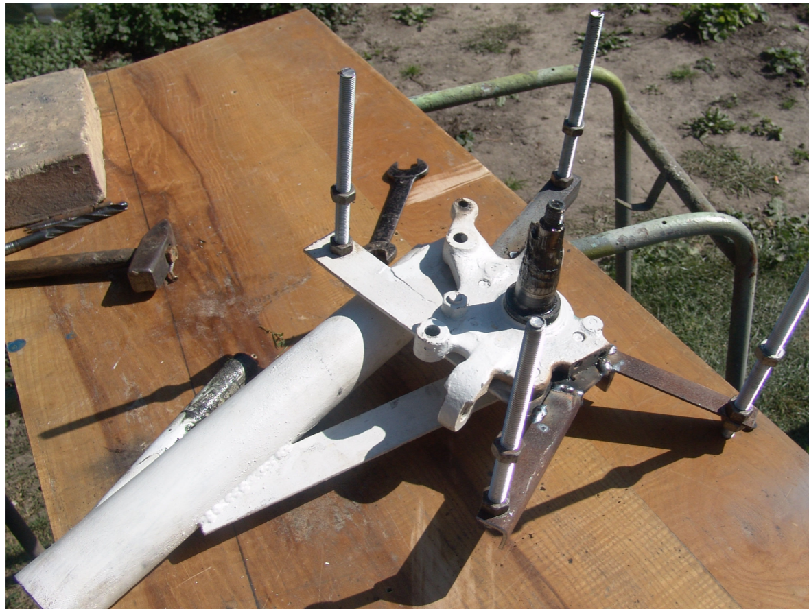
Obrotowa głowica wiatraka. Jest już zamocowana oś piasty rotora i cztery nagwintowane druty 12 do zamocowania statora. Z lewej strony głowicy w ukośnie przyspawanej rurce będzie zamocowany na specjalnym przegubie ogon wiatraka.
