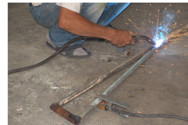
Spawanie konstrukcji ogona wiatraka, który zostanie zawieszony na zawiasie pokazanym na zdjęciu wyżej.
