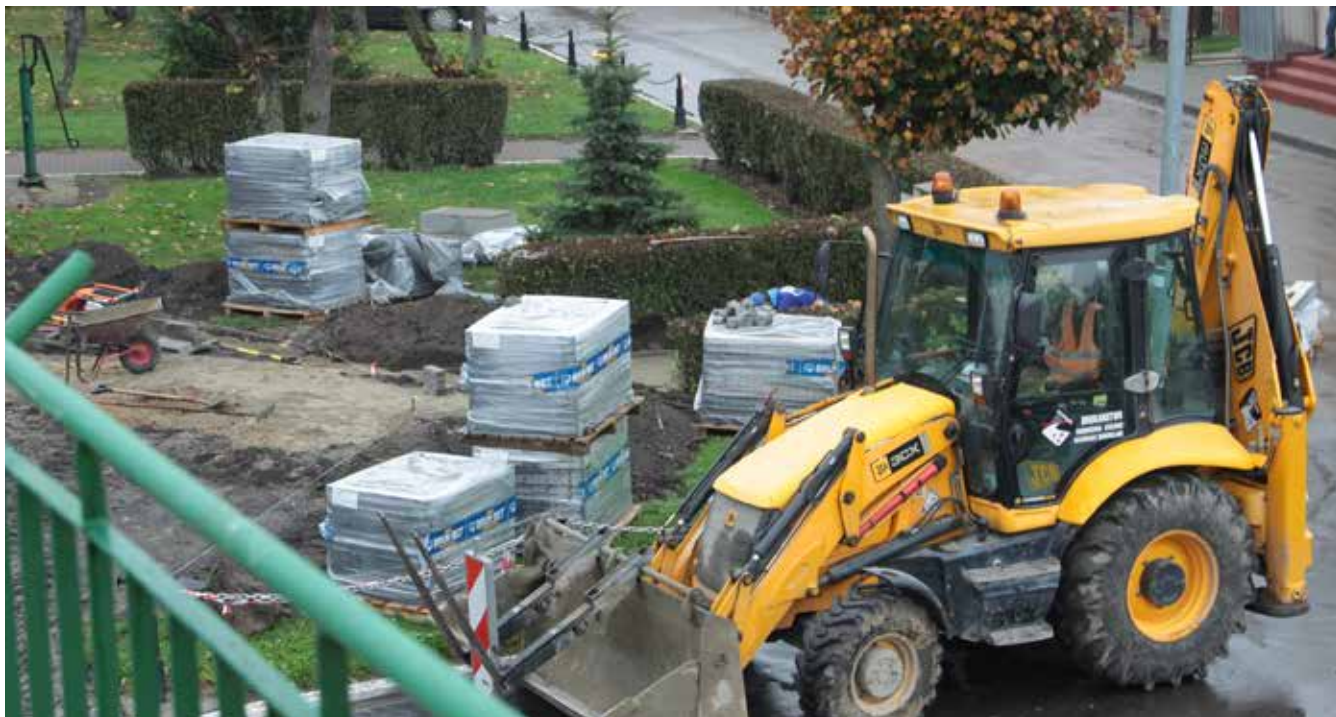
17.10.2014 r. Układanie kostki brukowej na skwerku w centrum Rynku w Grabowcu. Prace wykonała firma kamieniarska Mirosława Chudoby wyłoniona w drodze przetargu.
