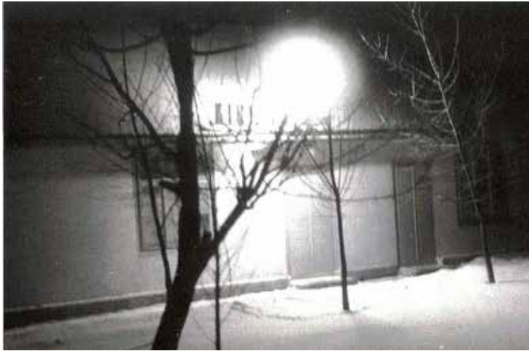
Lata 70-te XX w. Budynek kina w zimową noc. Fot. Tadeusz Halicki. Szyld „KINO START” był wykonany z drewnianych liter zamocowanych na krawędzi dachu na metalowym stelażu. Nad literami, na metalowym wysięgniku wisiła lampa z czterema świetlówki (jarzeniówki).
